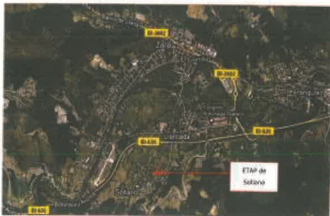
Fig. 2: Detalle de la situación de la ETAP de Soliano
