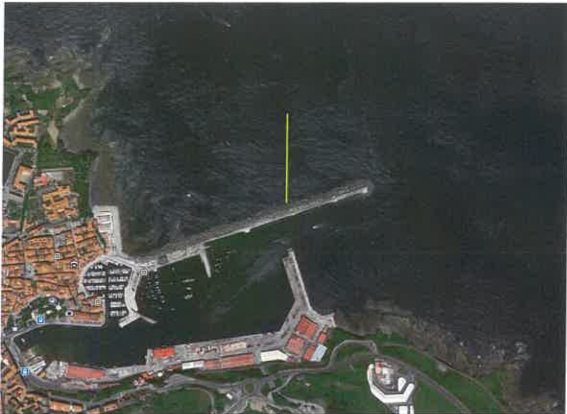
Fig. 1. Posición del emisario de la EDAR de Lamiaran (Bermeo).
