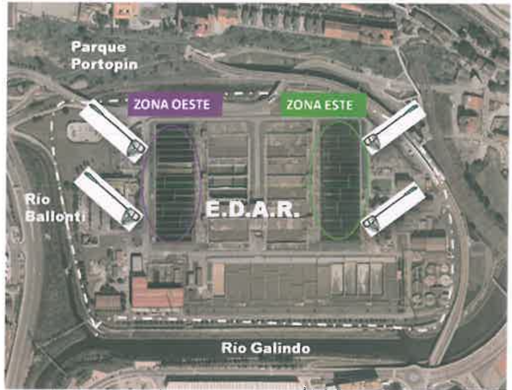
Figura 1: Fotografía aérea (tomada de Google Earth®) en la que se muestra la ubicación de los diferentes lugares de toma con red de muestras de agua en las instalaciones de la E.D.A.R.
