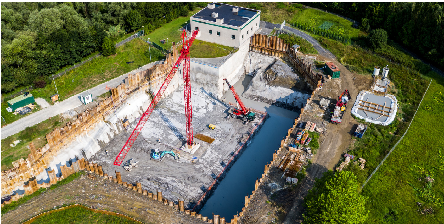
Mungiako Ekaitz andelaren lanak • Obras del Tanque de Tormentas de Mungia
