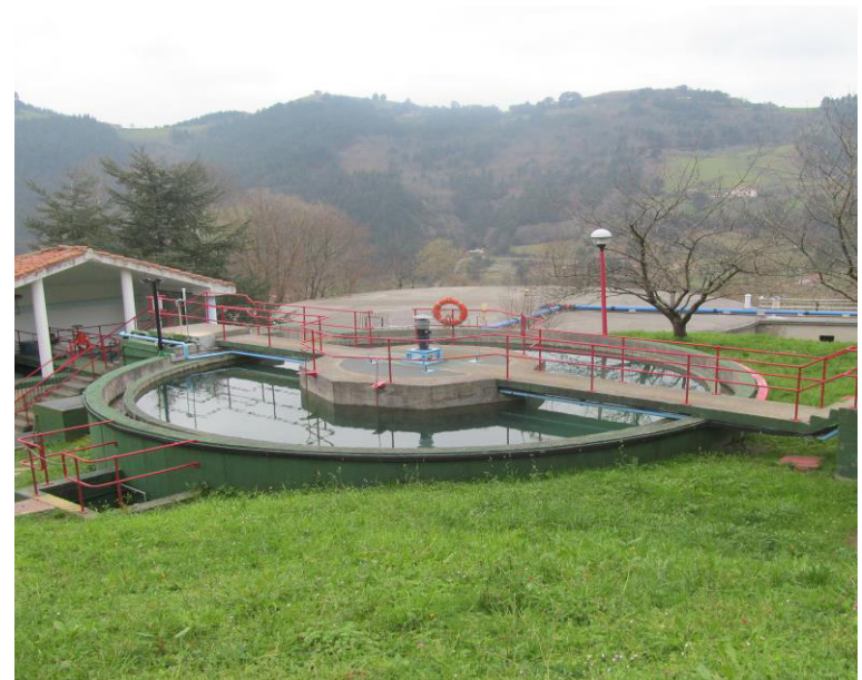
Gorozikako EUT • E.T.A.P. de Gorozika
