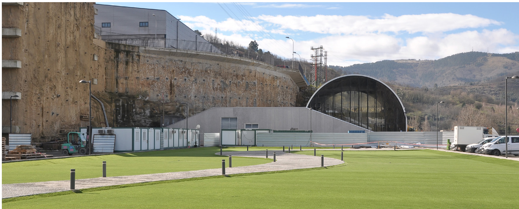
Etxebarriko ponategia • Bombeo de Etxebarri
