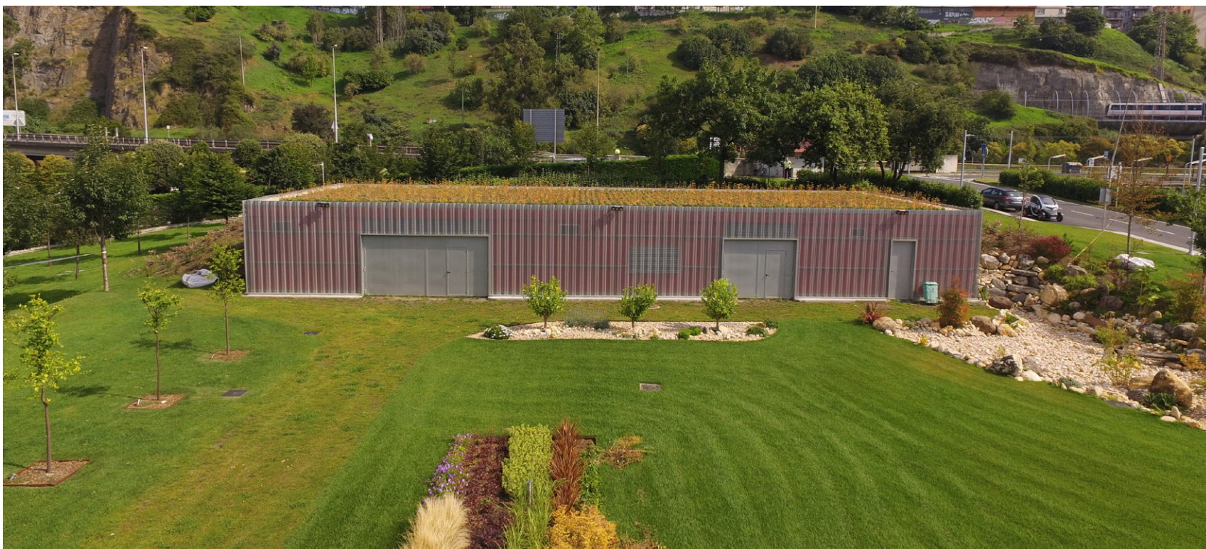
Galindoko HUAr tensoaren banaketa zentroa, Sestao • Centro de reparto de tensión. E.D.A.R. Galindo, Sestao
