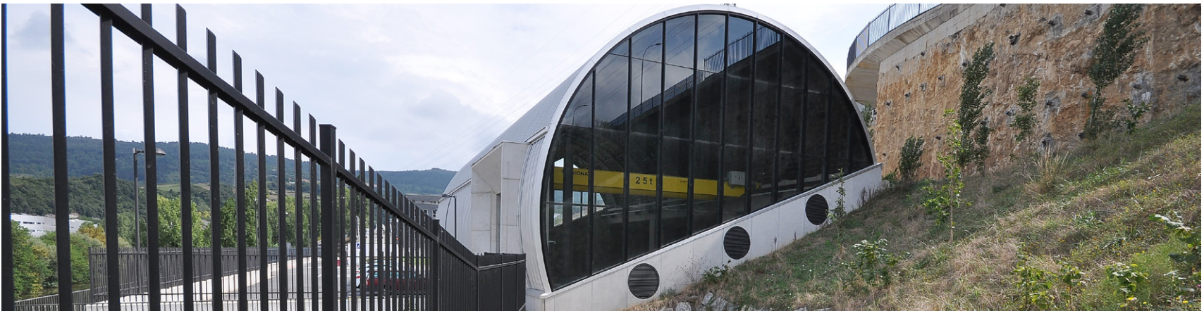
Etxebarriko ponpategiaren eraikina • Edificio del bombeo de Etxebarri
