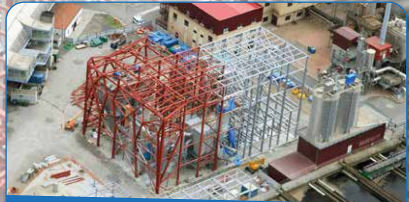
Construcción Horno 3 (Galindo)
